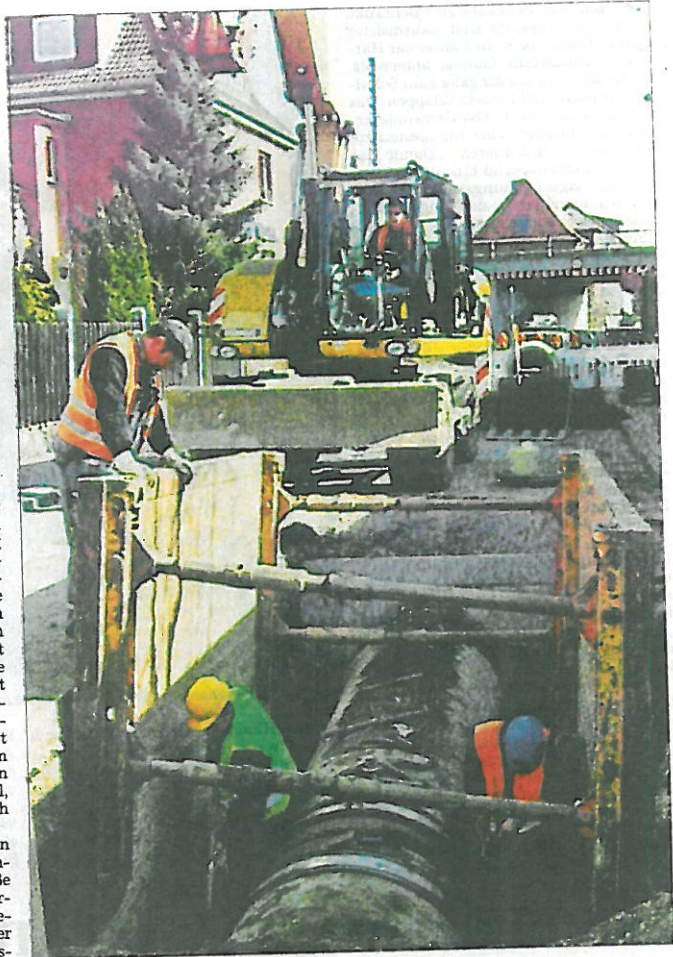
500 Meter des Kanalnetzes werden demnächst in drei Straßen ersetzt – die Rohre werden einen ähnlichen Durchmesser bekommen wie in der Neuen Straße.
