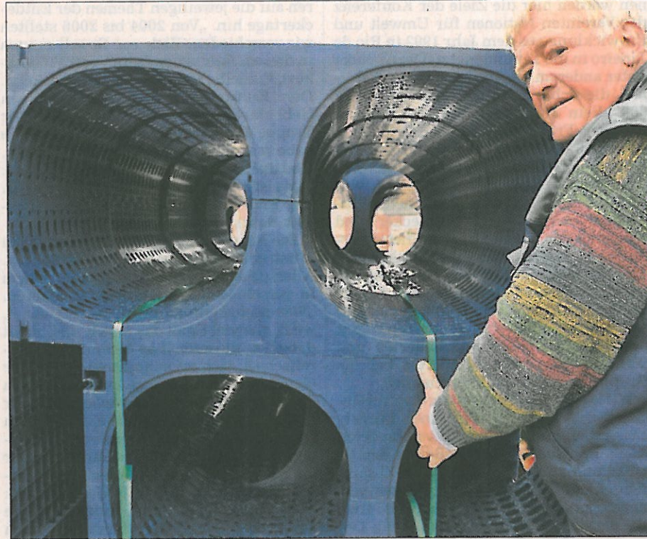
Wie Lego für Erwachsene: Polier Gerald Brüggemann bei den neuen Speichermodulen für das Algermisser Regenwasser. Foto: Klink
